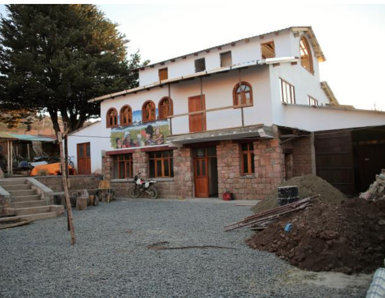
Neues Ausbildungszentrum mit Schulungszimmern und Schlaßsälen
