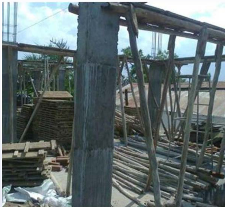
Die Deckeschalung wird mit einfachen Holzspriessen gestützt.
