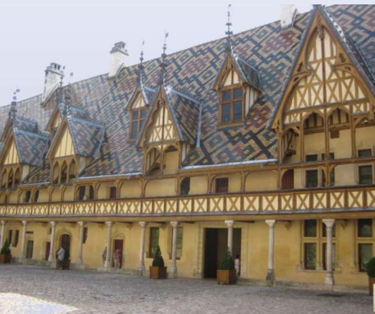
Hôtel-Dieu (Krankenhaus aus dem Mittelalter)
